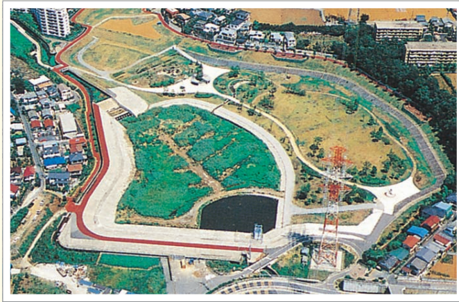
調節池の設置
