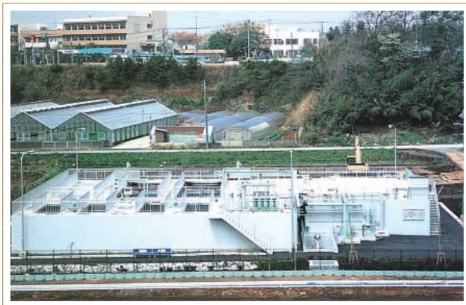
河川浄化施設の建設
