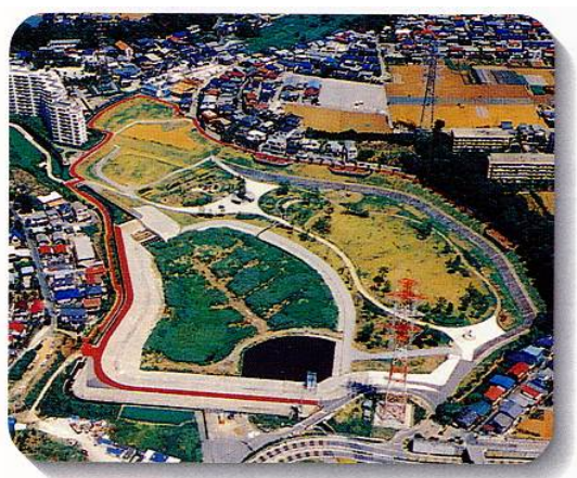
調節池の設置
