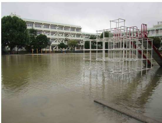
船橋市立高郷小学校（令和元年10月25日の大雨時）
