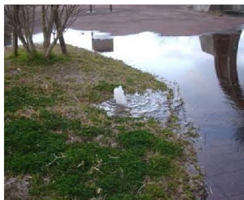
水道管の損傷によりあふれ出た水
