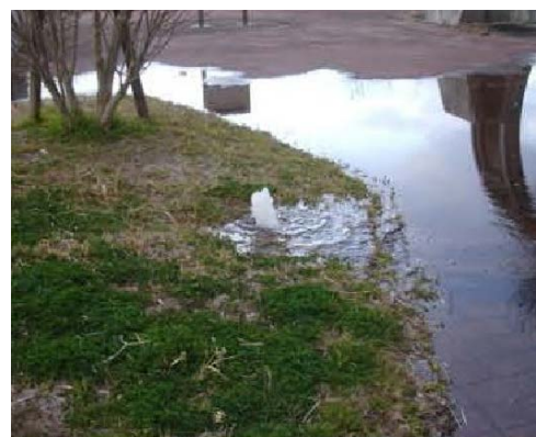
水道管の損傷によりあふれ出た水
