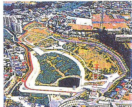
長津川調節池の多自然型川づくり (船橋市前貝塚町)
